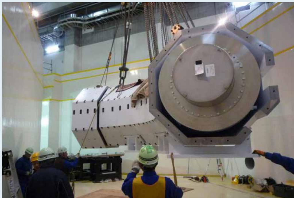
Installation de l'aimant de transport des muons dans le Hall COMET à J-PARC.
