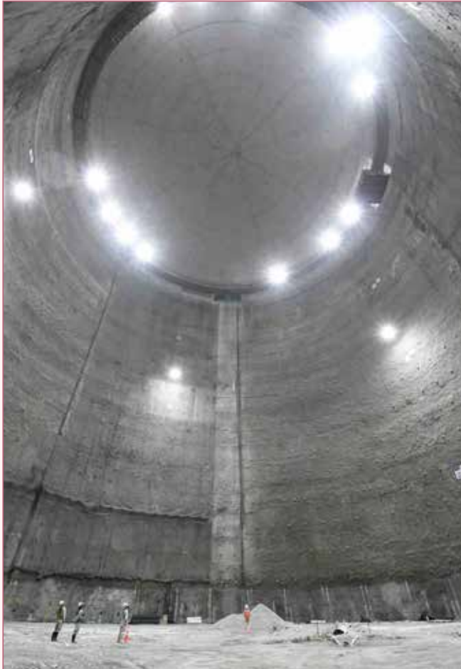
Photo 5 : La caverne de Hyper-Kamiokande à la fin de l'excavation.
