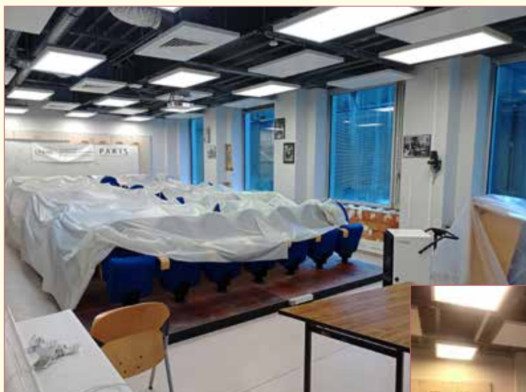
Salle des séminaires bâchée en prévision des travaux.
