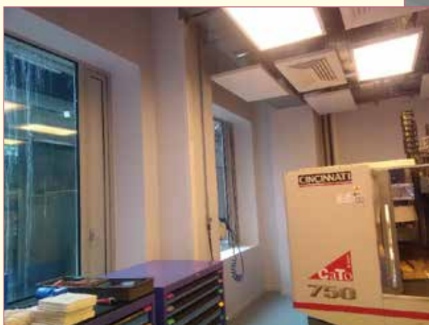
Atelier mécanique après réfection.
