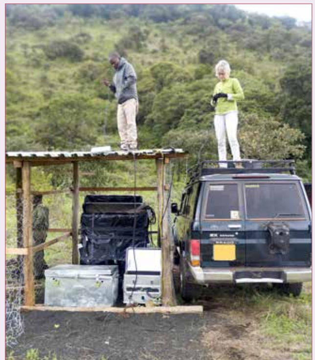
Opération de maintenance de l'alimentation électrique d'un détecteur de muons installé dans la chaîne des Chyulu au Kenya afin d'observer les variations saisonnières de son contenu en eau.
