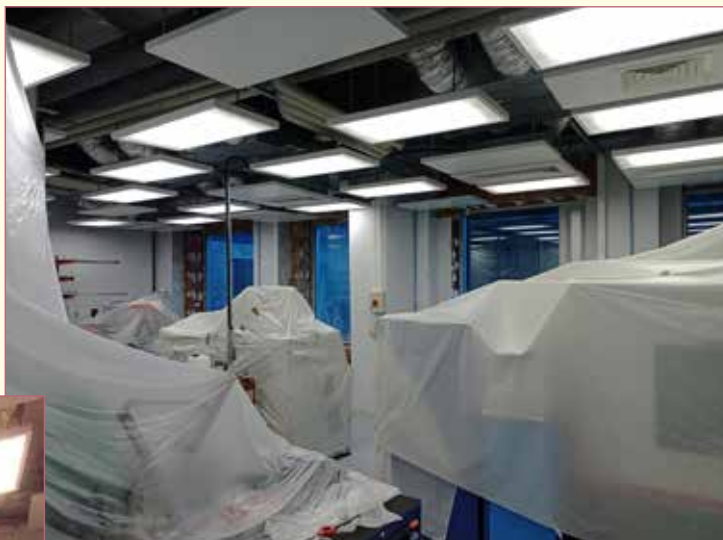
Atelier mécanique bâché en prévision des travaux.
